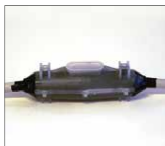
4.- Polimerización Dejar en reposo durante aproximadamente 15 minutos para alcanzar la polimerización adecuada del compuesto.
